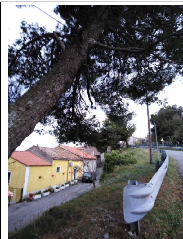
Missione 6.3. - Int. 6.3.7.1 strada Santa Caterina - Foto 1
