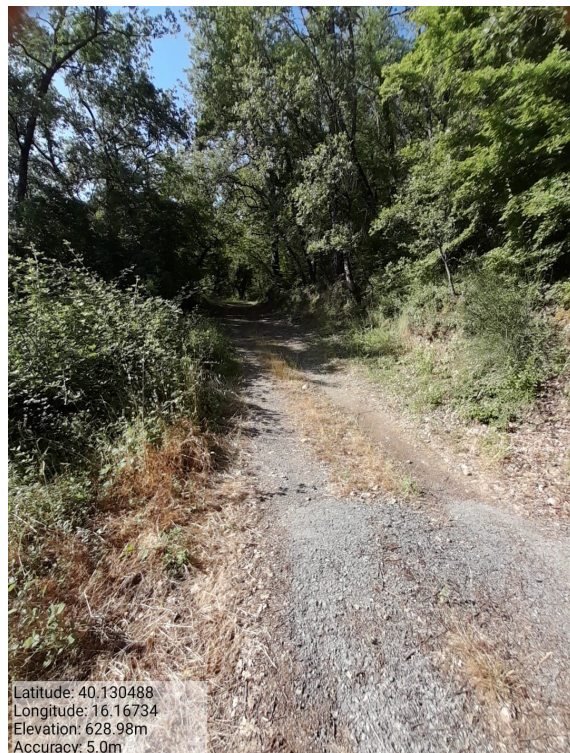
Int. 6.3.4.1 - Strada Polazza - Mastro Vittorio - Foto 1
