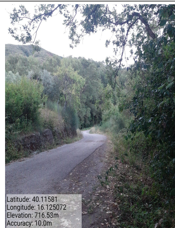
Int. . 6.3.13.1 - Strada Monte - Foto 1
