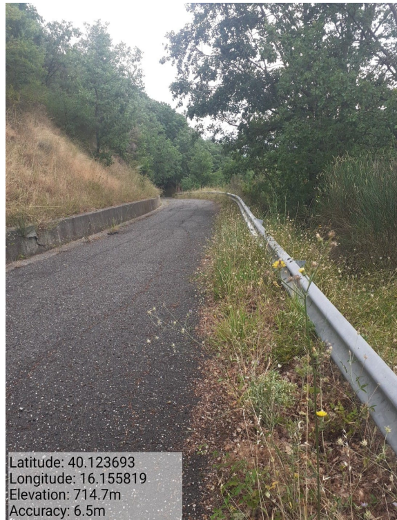
Int. 6.3.8.1 - Strada Vallone - Spilia - Foto 1
