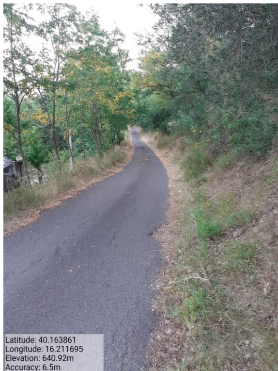
Int.6.3.15.1 - Strada Spadarea – Foto1
