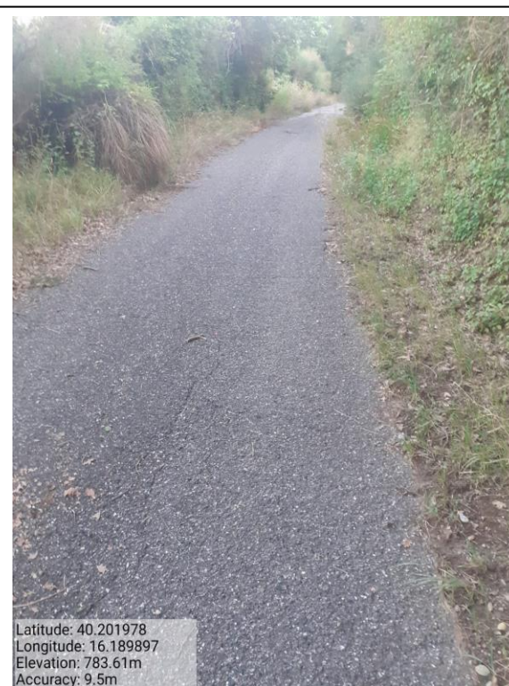
Int.6.3.4.1 – Strada Scorticata – Foto 1
