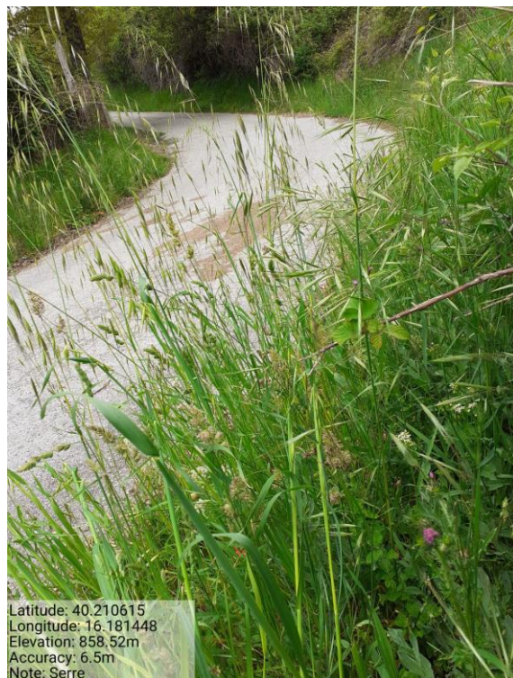
Int.6.3.18.1 – Strada Serre – Foto1
