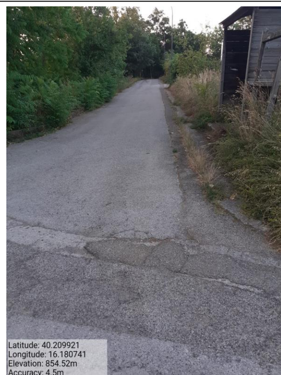
Int.6.3.12.1 – Strada Murgitelle– Foto 1
