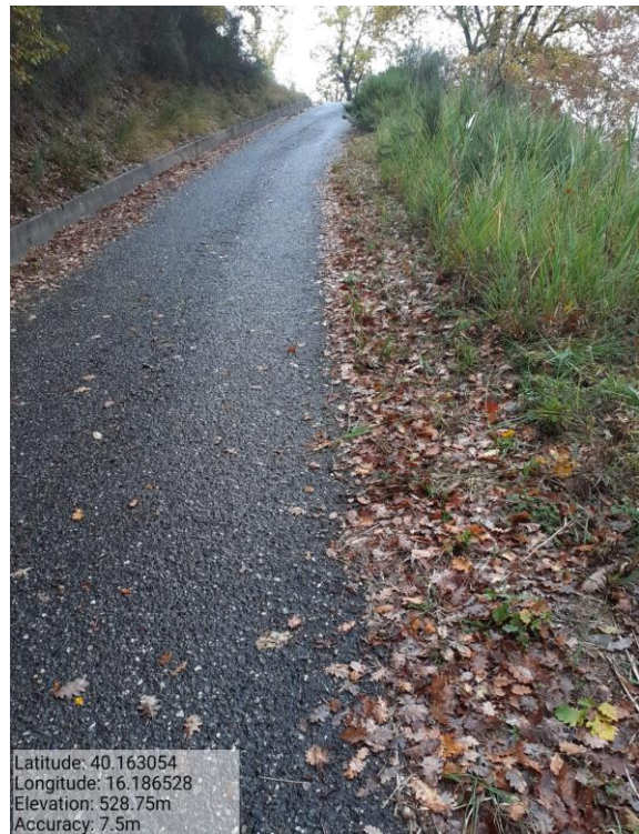
Int.6.3.14.1 – Strada Celagresti – Foto1
