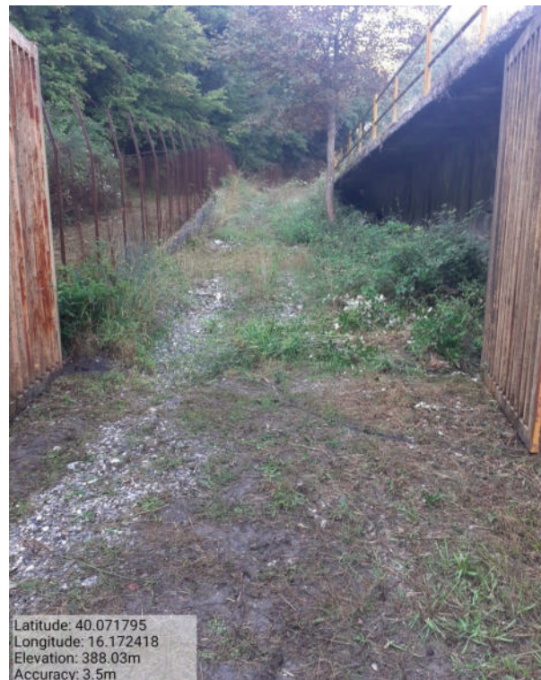
Int.6.3.18 Loc. strada Vasca - Foto1
