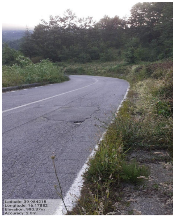
Int.6.3.13 Loc. strada SP102 di Mezzana - Foto1
