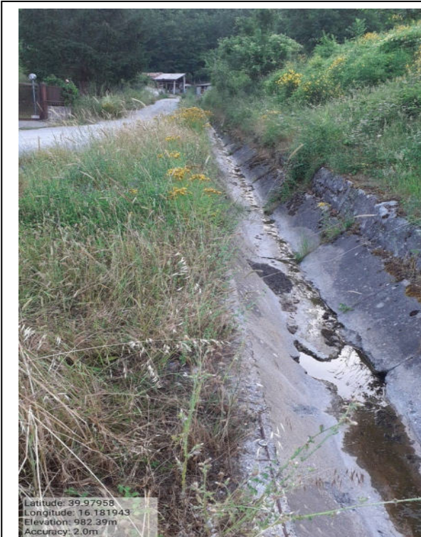
Int. 6.2.1 Loc. canaletta Mezzana – Foto 1
