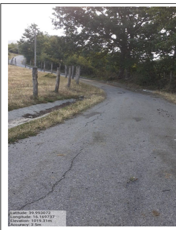
Int. 6.3.15 Loc. Mezzana –Torre Superiore – Foto 1
