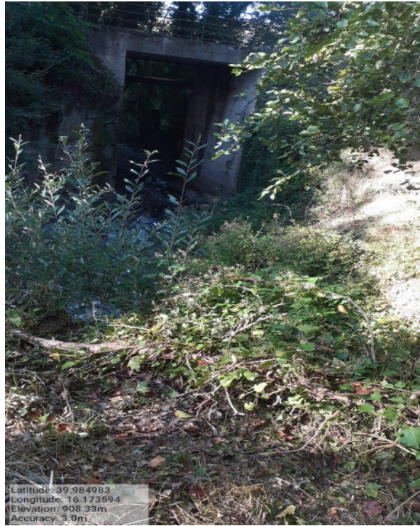
Int.6.1.9 Loc. Fosso Torre - Foto1
