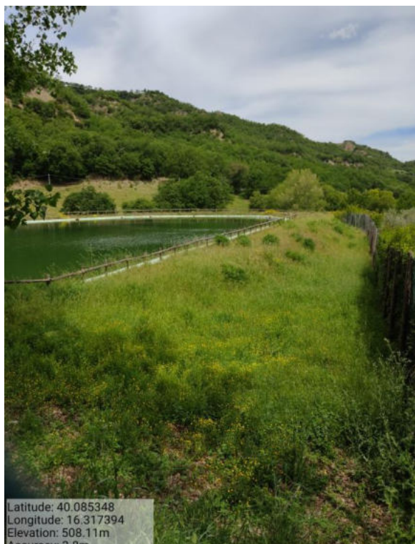
Int. _2.1.1_ Manutenzione Aree Attrezzate Foto 4
