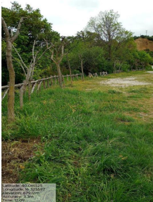
Int. _6.4_ Manutenzione Staccionate Foto 2
