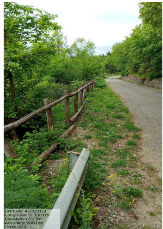
Int. _6.4_ Manutenzione Staccionate Foto 3
