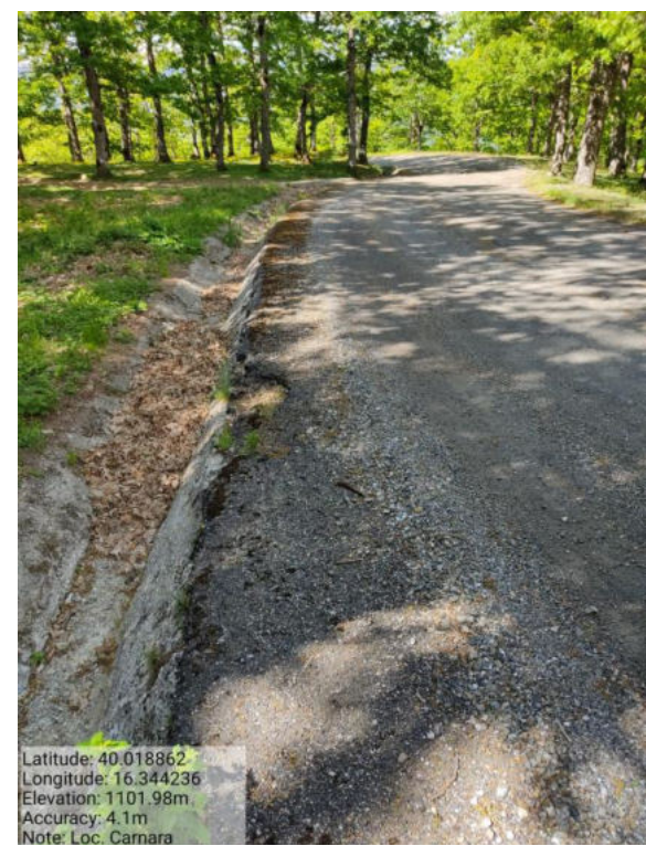
Int. _6.3_Manutenzione Strade Foto 3
