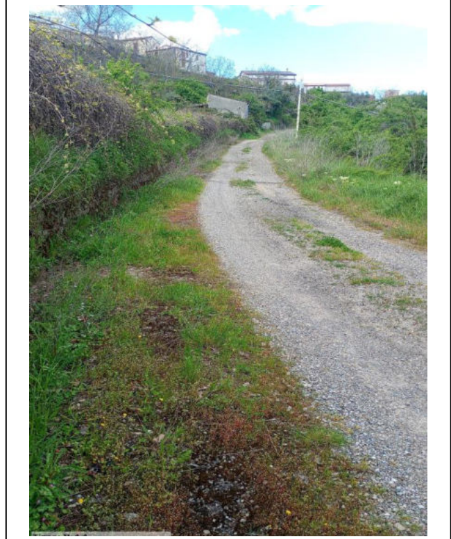
Int. _6.3_Manutenzione Strade Foto 2
