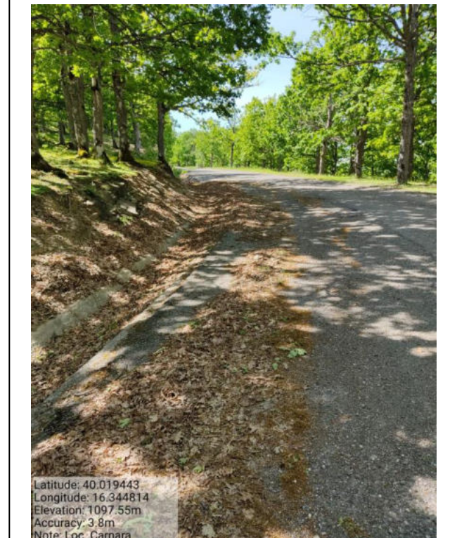
Int. _6.3_Manutenzione Strade Foto 4
