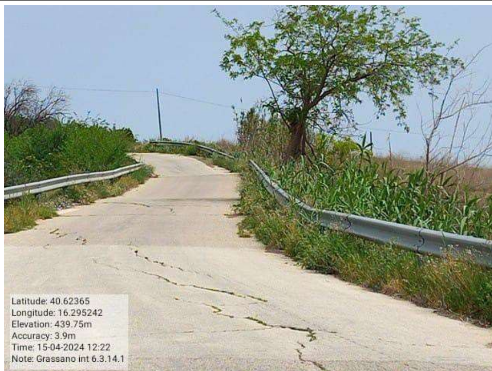
INTERVENTO 6.3.14.1 Grassano Fg.31-27-23-16-17 Strada Comunale Petrullo
