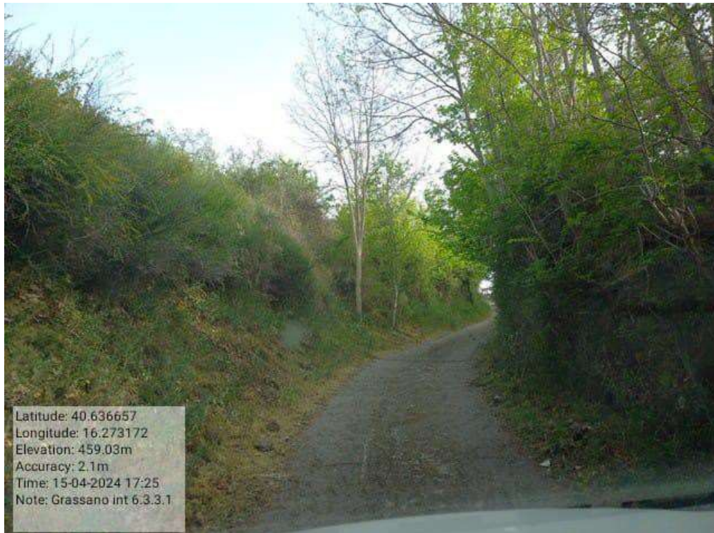
INTERVENTO 6.3.3.1 Grassano Fg.6 -3 Strada Comunale Manche 1
