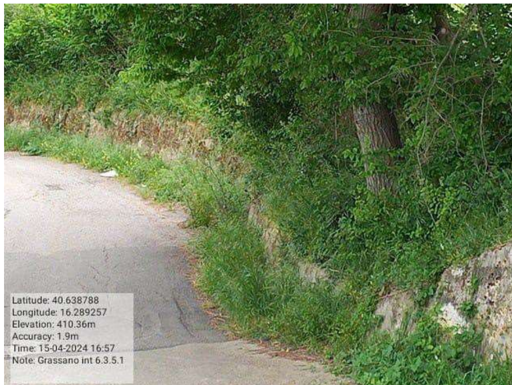
INTERVENTO 6.3.5.1 Grassano Fg.13-7-8 Strada Comunale Acqua Salsa
