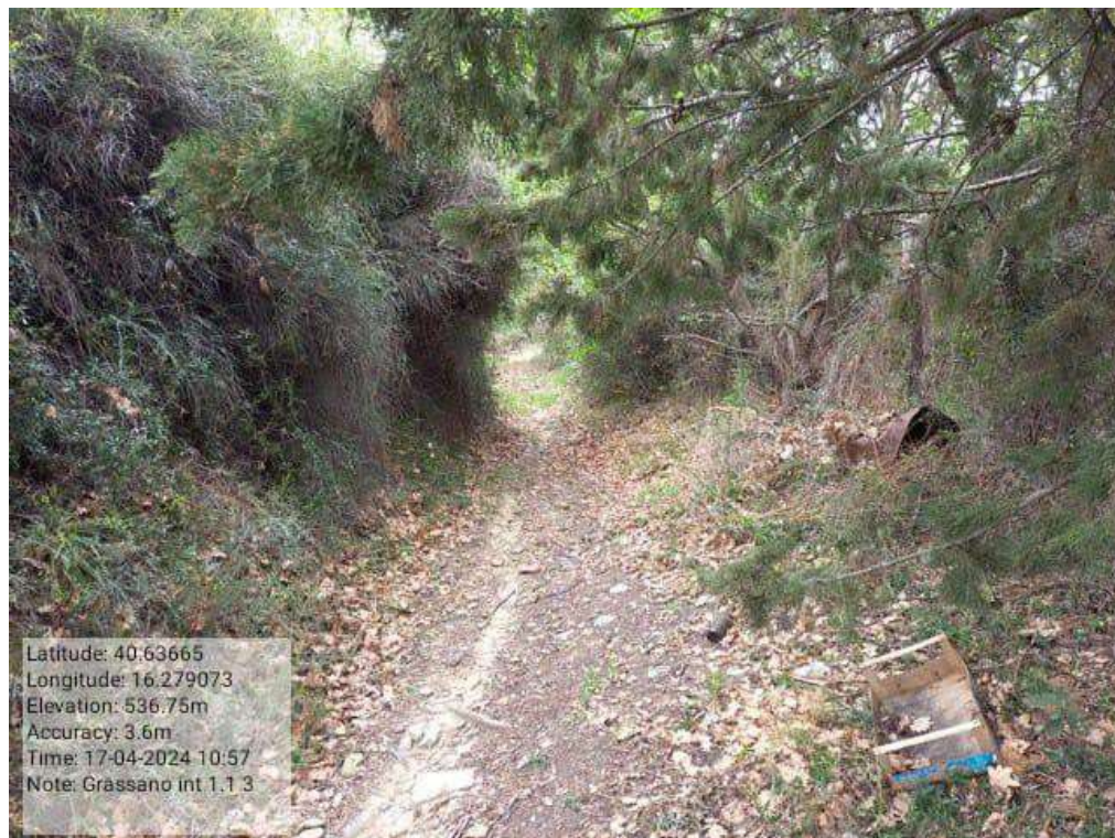
INTERVENTO 1.1.3 Grassano F.6-12 Part. Strada Comunale 2 Cinti - Fascia tagliafuoco attivo vede Foto n. 28
