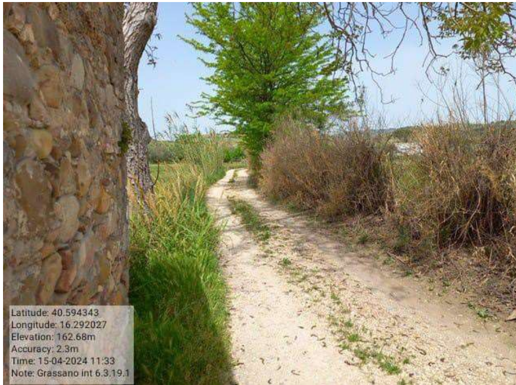
INTERVENTO 6.3.19.1 Grassano Fg.30-31 Strada Comunale Macchitelle 1
