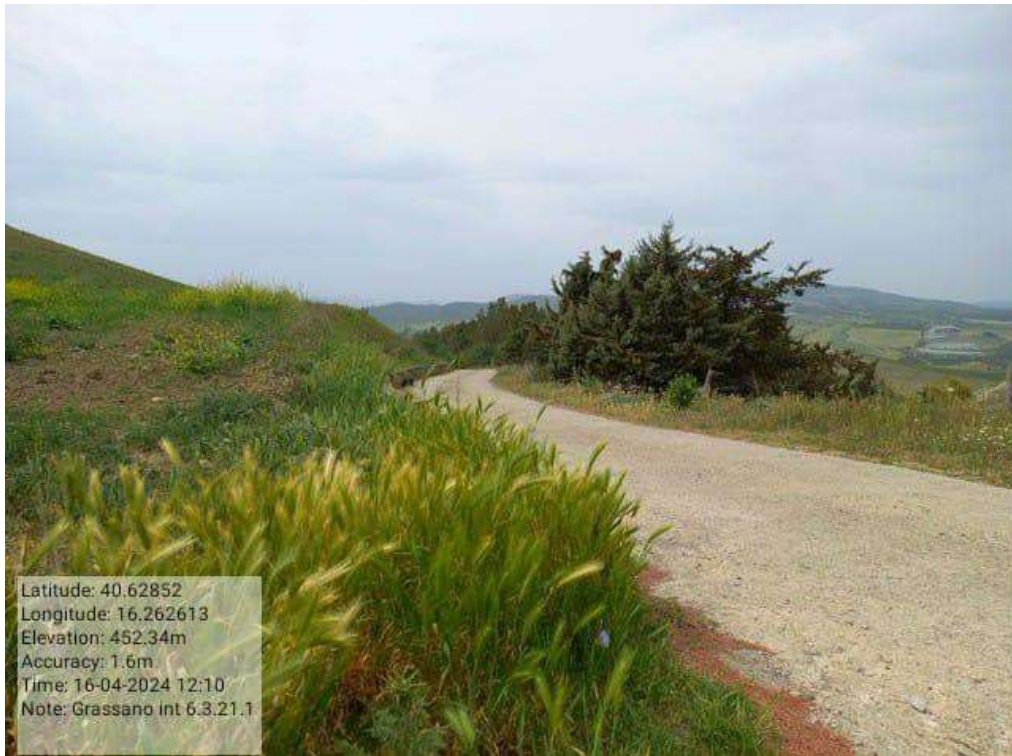
INTERVENTO 6.3.21.1 Grassano Fg.11-10-18-24 Strada Comunale Cugno di Noce
