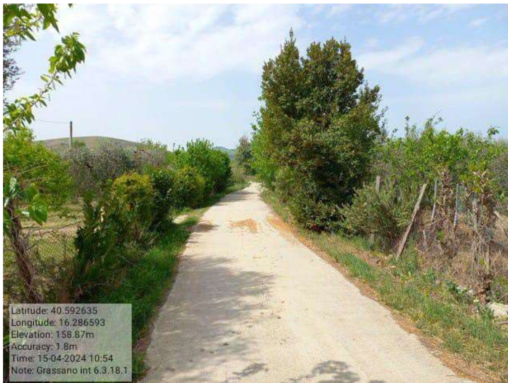
INTERVENTO 6.3.18.1 Grassano Fg.30 Strada Comunale Spineto
