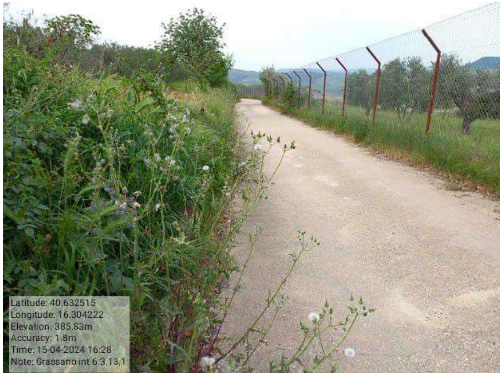
INTERVENTO 6.3.13.1 Grassano Fg.13-14 Strada Comunale S. Lucia
