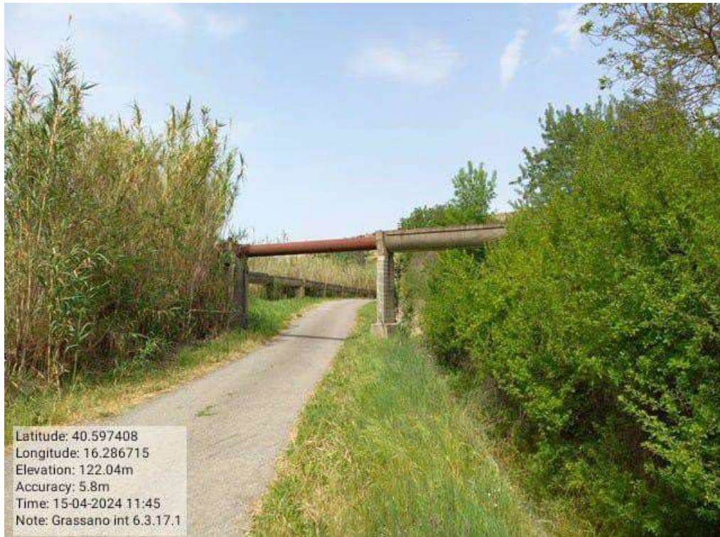
INTERVENTO 6.3.17.1 Grassano Fg.26-29-28 Strada Consortile Distretto 3
