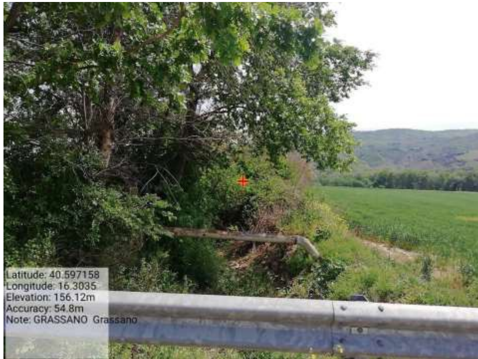
INTERVENTO 6.15.1 Grassano Fg.31 Canale Macchitelle + F.27 St. Com. Spineto e F.sso Spineto Foto n 39
