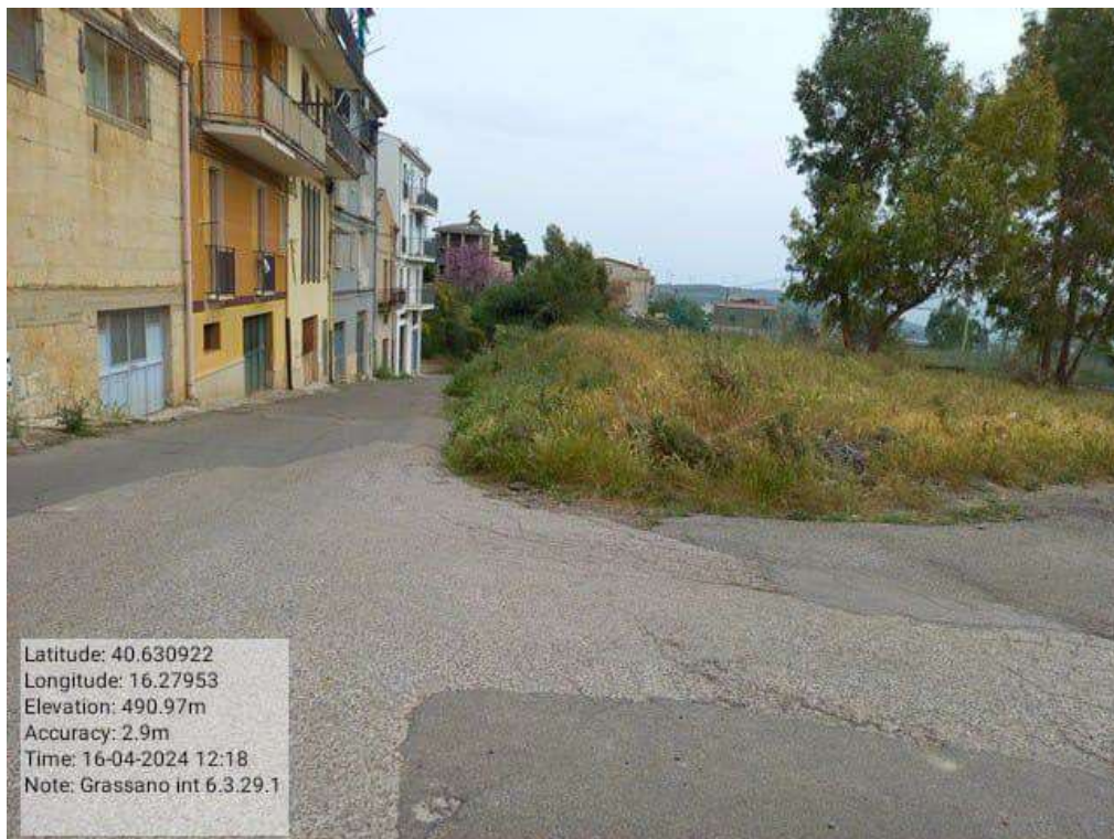
INTERVENTO 6.3.29.1 Grassano Fg.15 Via Cimitero Foto n. 24
