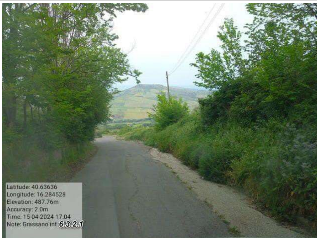
INTERVENTO 6.3.2.1 Grassano Fg.6-4 strada Comunale Tilea
