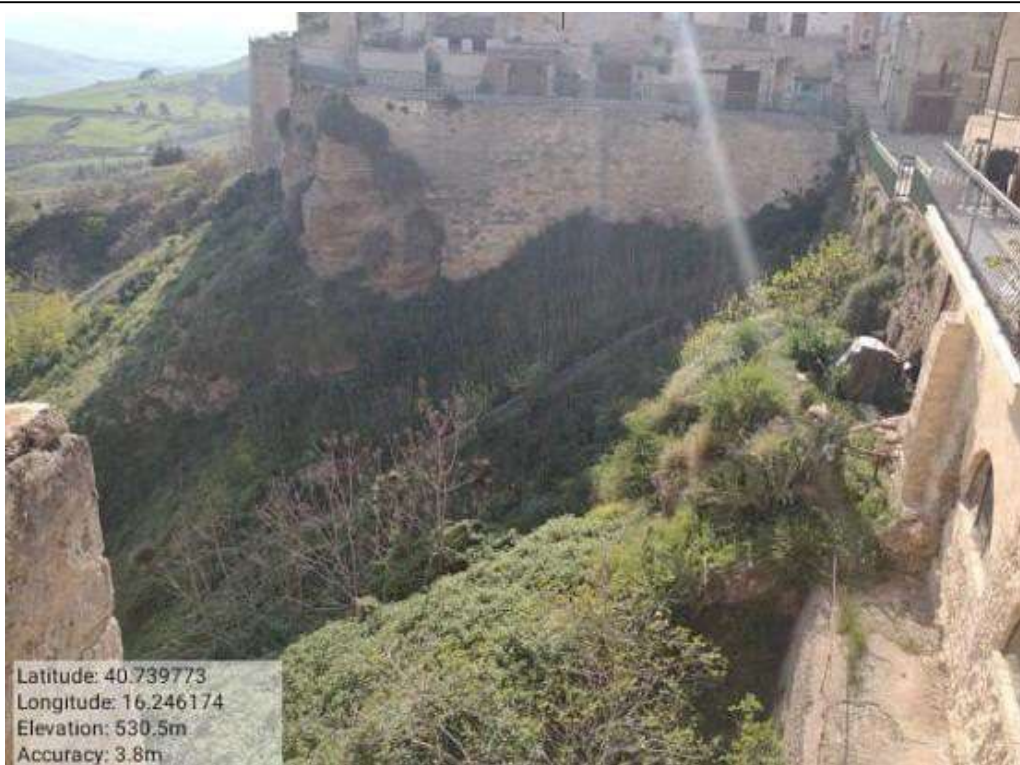
Int. 6.1.1 Irsina Fg.44 part.94-89-90-95-97 Fosso dei Greci - tratto monte
