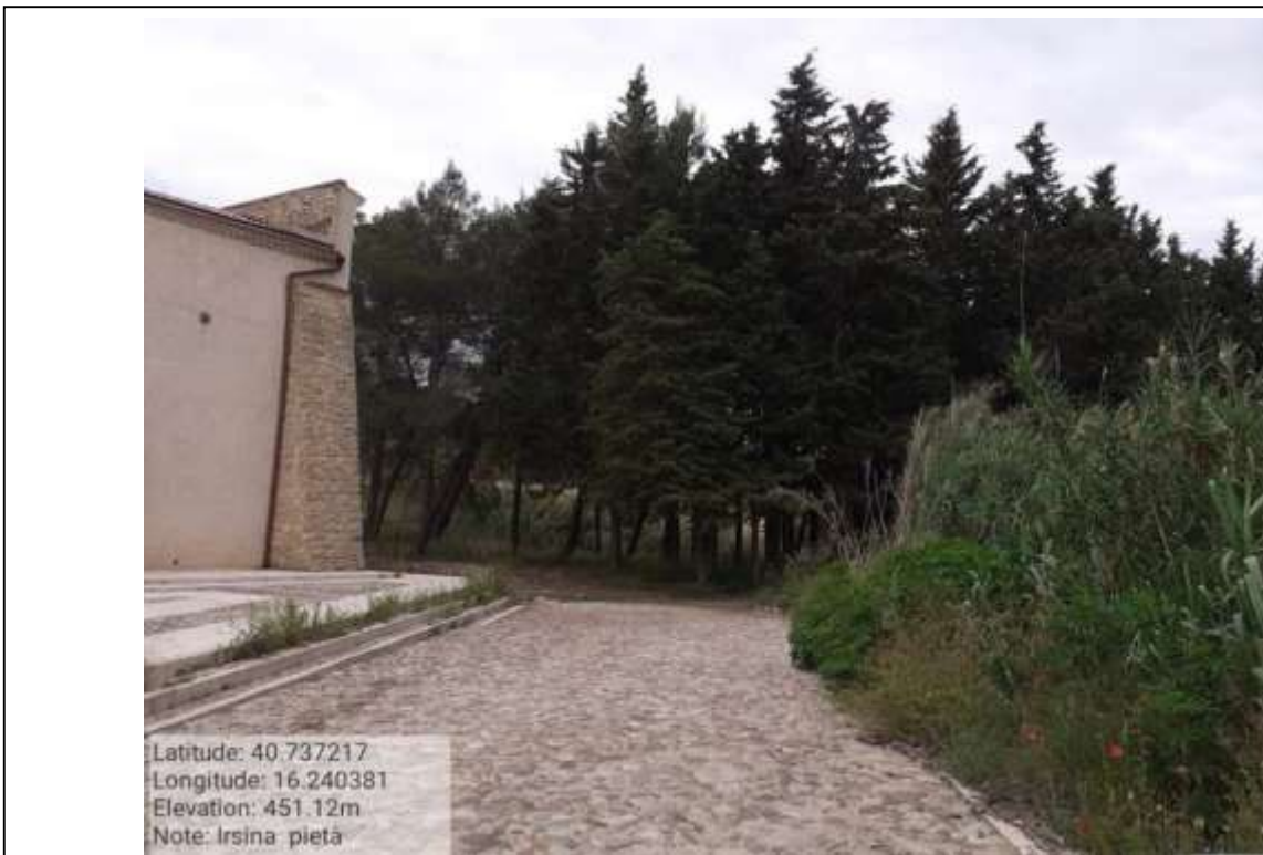
Int. 6.4.2 Irsina Fg.43 Part. Strade- ZONA CHIESA PIETA'
