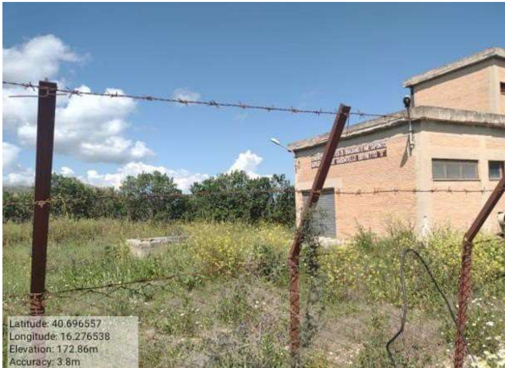
Int. 6.1.4 Irsina Fg.74 p.240 Impianto di sollevameto Distretto "S"
