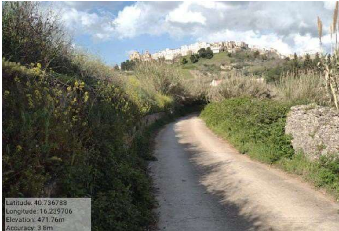
Int. 6.3.4.2 Irsina Fg.44 Strada comunale la Pietà
