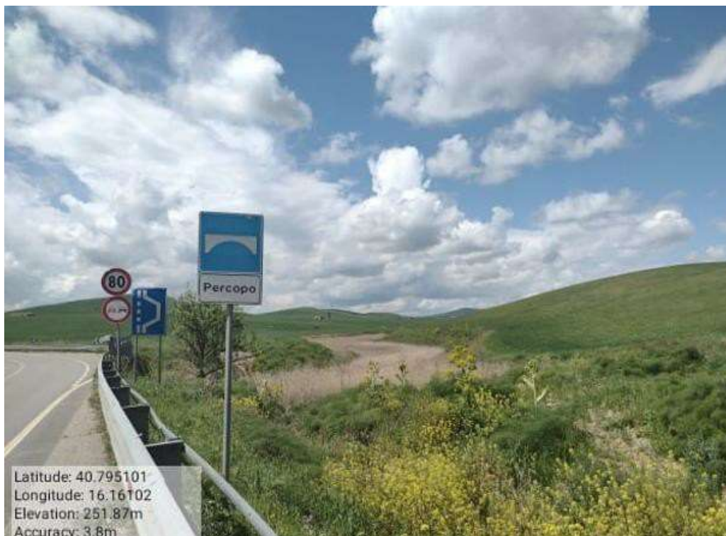
Int. 6.1.7 Irsina Fg.39 part. AcqueTORRENTE PERCOPO
