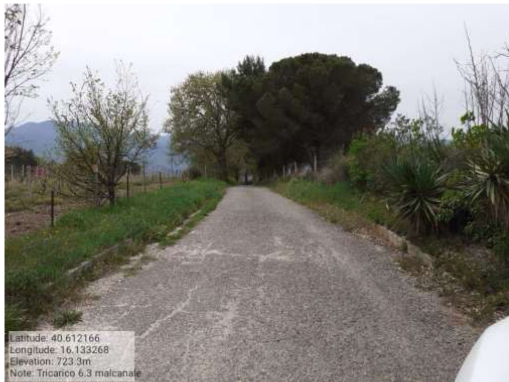
INTERVENTO 6.3.4.1 - TRICARICO STRADA COMUNALE MALCANALE FG. 64
