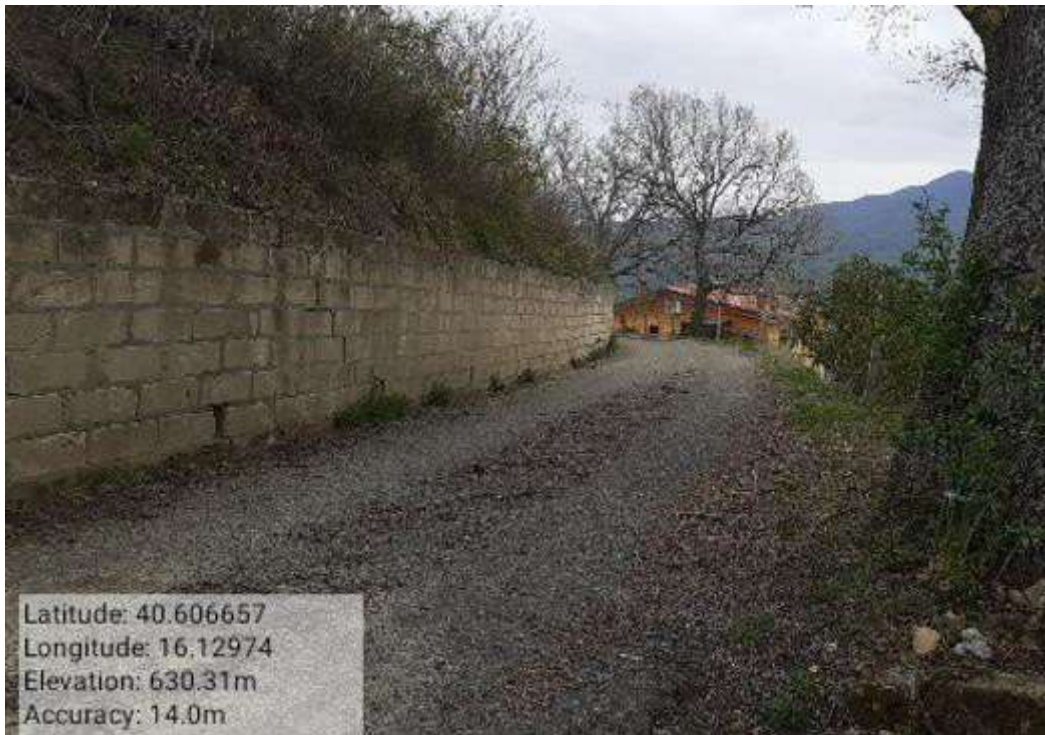
INTERVENTO 6.3.8.1.- TRICARICO STRADA COMUNALE MALCANALE 6 FG. 64
