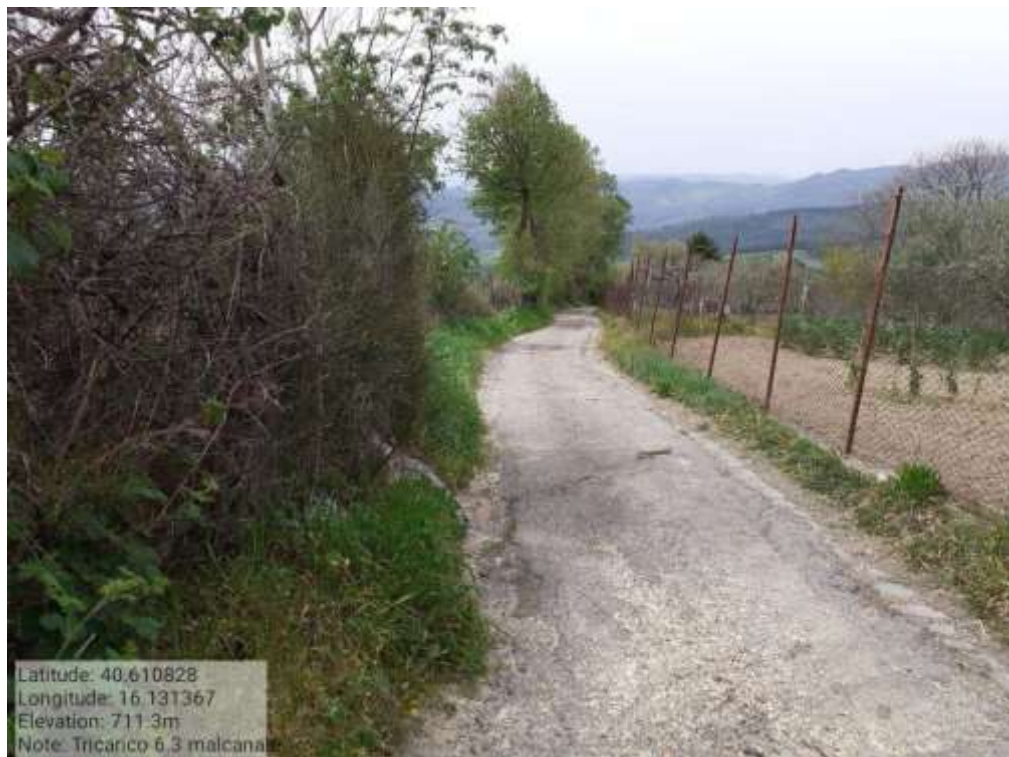
INTERVENTO 6.3.4.1- TRICARICO STRADA COMUNALE MALCANALE 5 FG. 64 Foto n. 45
