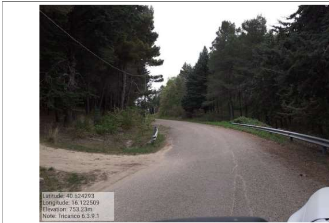
INTERVENTO 6.3.9.1 - TRICARICO STRADA COMUNALE SALUMICIFIO FG 59
