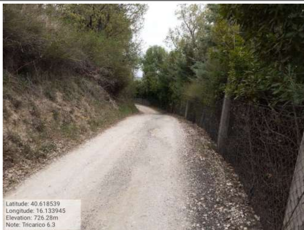
INTERVENTO 6.3.7.1 - TRICARICO STRADA COMUNALE SAN MARTINO FG. 60 Foto n.46
