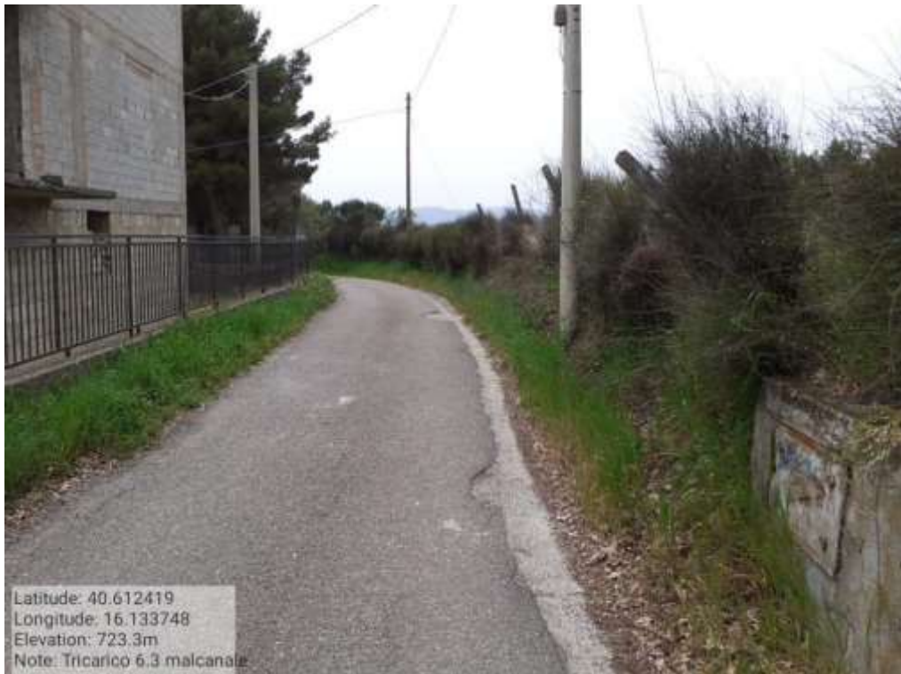
INTERVENTO 6.3.3.1.- TRICARICO STRADA COMUNALE MALCANALE 1 FG. 64
