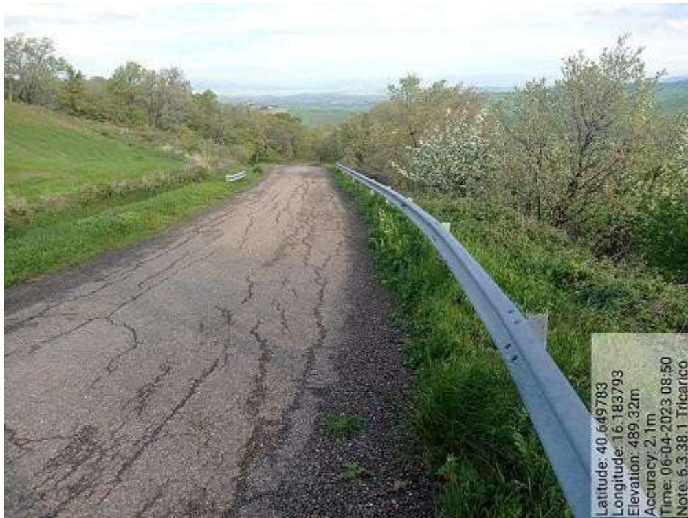
INTERVENTO 6.3.38 - TRICARICO Fg.38 Part.143 e Strade - Strada Comunale Pantano di Volpe Foto n.77
