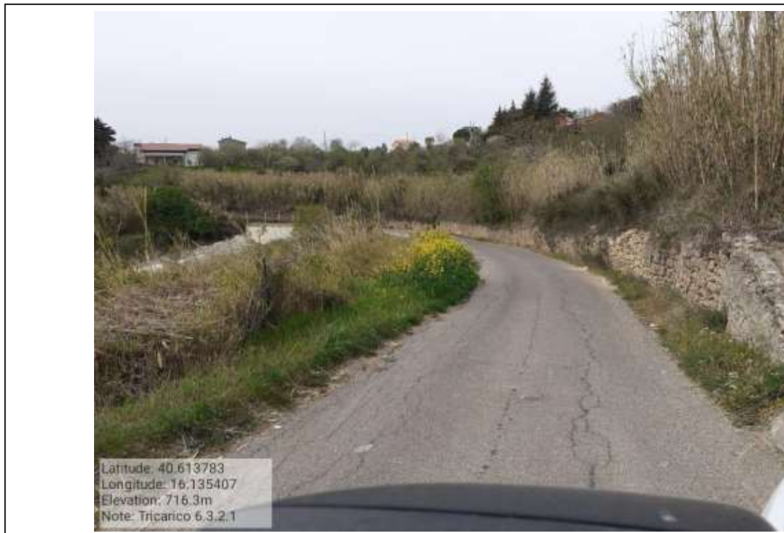
INTERVENTO 6.3.2.1 - TRICARICO STRADA COMUNALE MALCANALE 3 FG. 64
