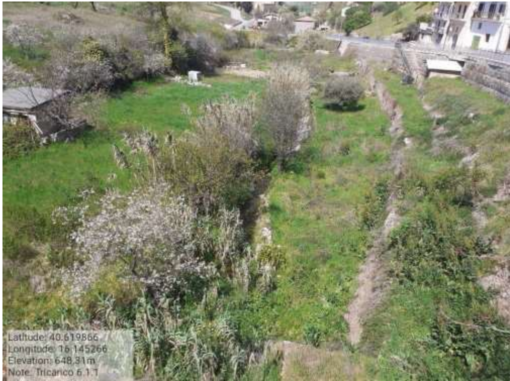
INTERVENTO 6.1.1 - TRICARICO VALLONE CACARONE fg.6 1° TRATTO Foto n. 29
