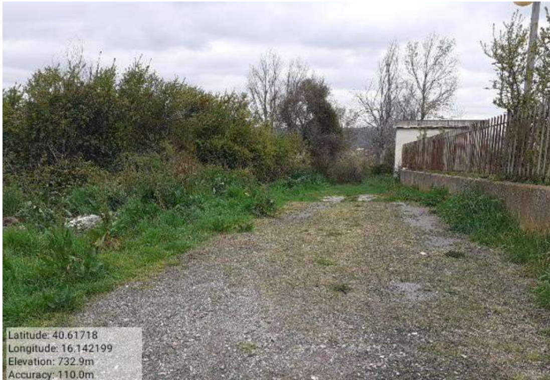
INTERVENTO 6.1.5 Tricarico Fg.65 Pretura - Fontana Vecchia
