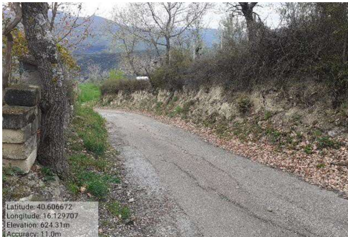
INTERVENTO 6.3.10.1- TRICARICO STRADA COMUNALE MALCANALE 7 FG. 64
