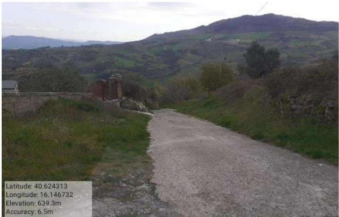
INTERVENTO 6.3.21 - TRICARICO Fg61 Strada Comunale della Trinità Foto n.61
