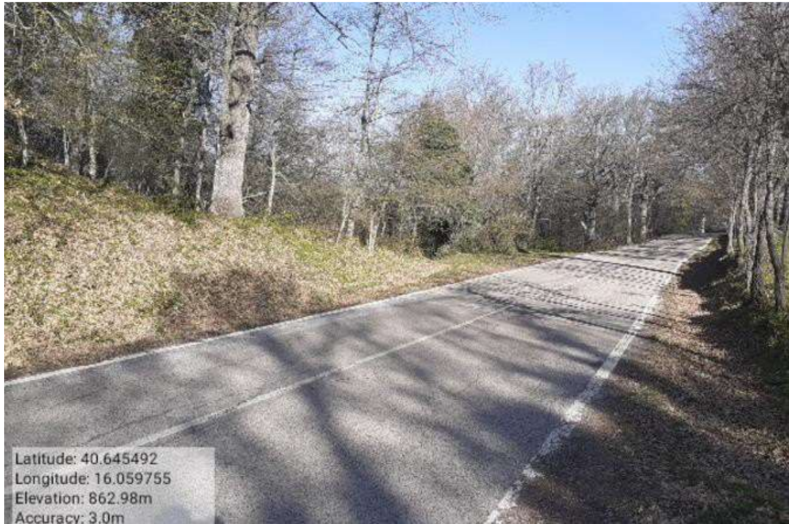
INTERVENTO 1.2.4- TRICARICO Part. Tricarico Fg.50 171 Loc.Trecancelli Foto n. 9
