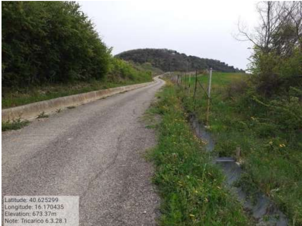
INTERVENTO 6.3.28.- TRICARICO TRATT TRICARICO GRASSANO 2° TRATTO SERRA DEL CEDRO PANTANA FG .56-57 Foto n. 68
