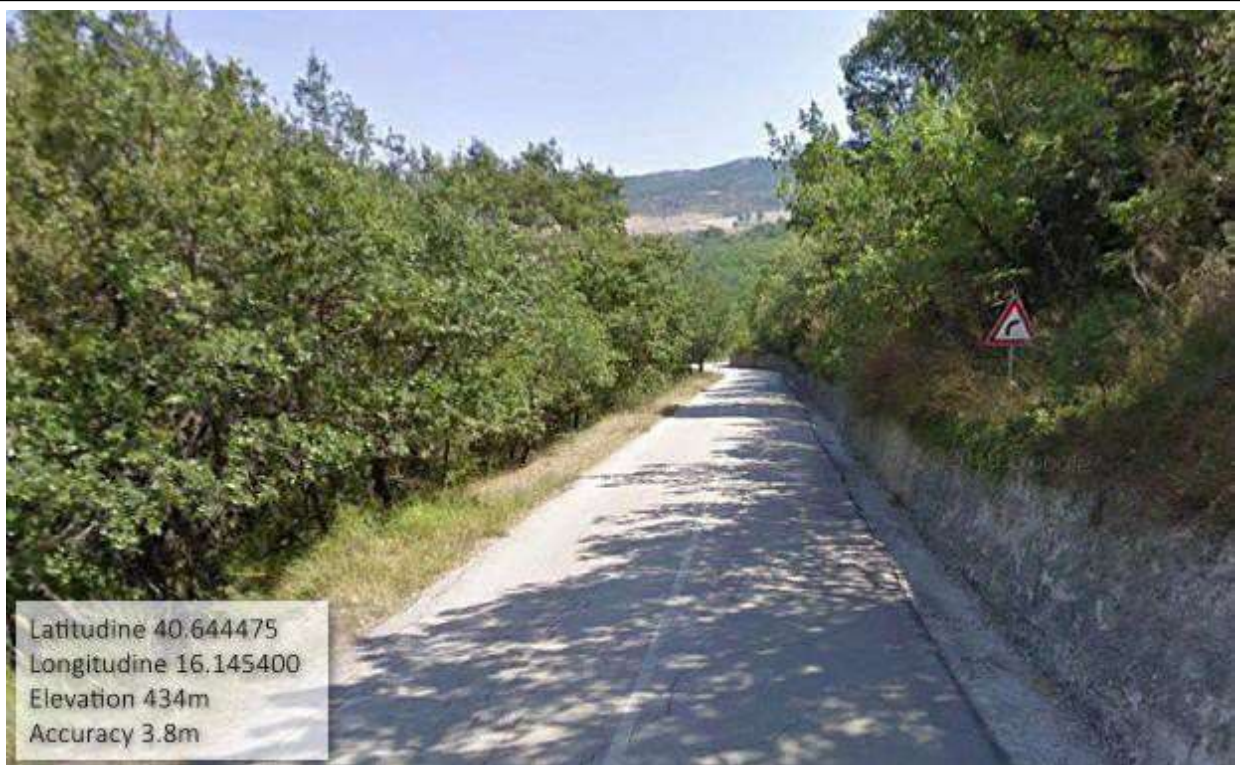
INTERVENTO 6.3.23 - TRICARICO STRADA PROVINCIALE BOCCANERA FG.46-47-35-36-21 1° TRATTO Foto n.63
