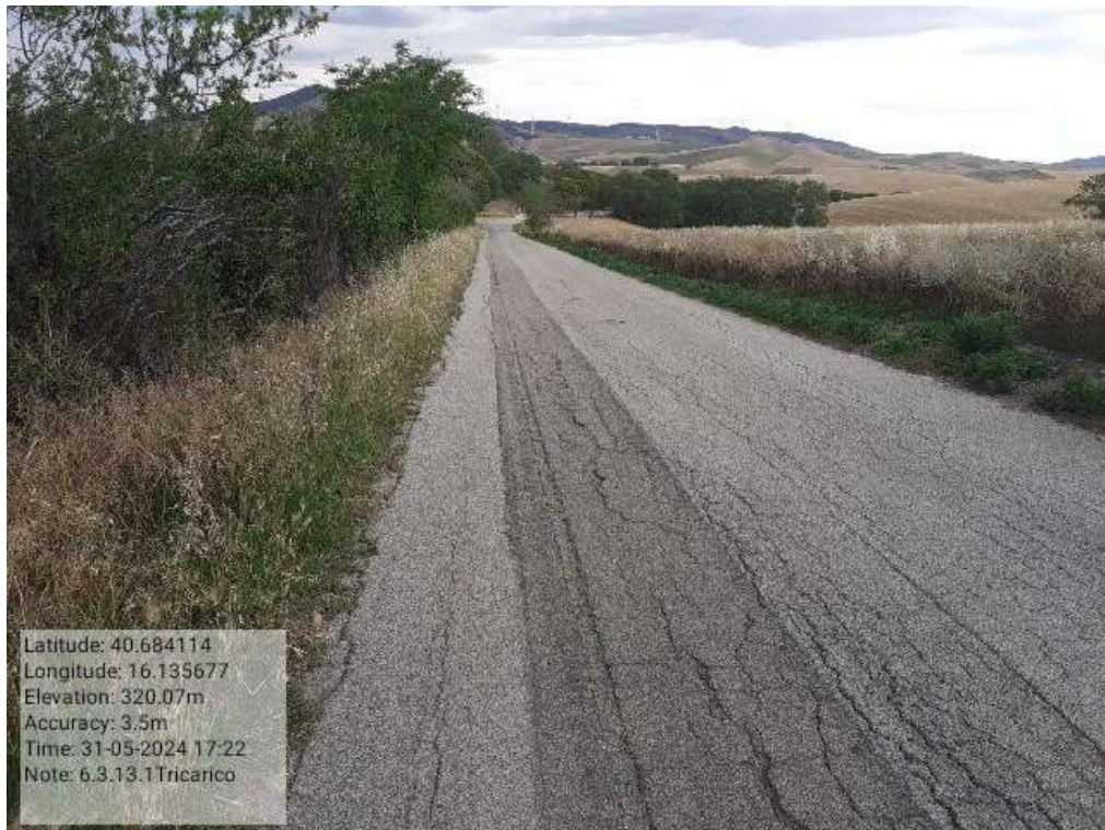
INTERVENTO 6.3.13 - TRICARICO Fg. 46-45-33-34-11-12-4 Strada Comunale Albanello-Cucno della Pica Foto n. 52
