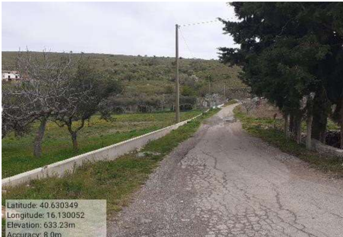
INTERVENTO 6.3.16.- TRICARICO STRADA COMUNALE SANT ANDREA MANCARRONE FG. 53/45 Foto n. 56
