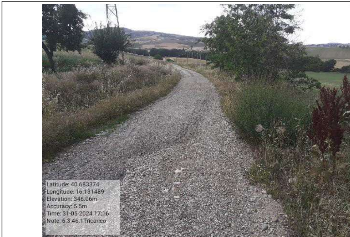
INTERVENTO 6.3.46.1 Tricarico Strada per il Casone 82
