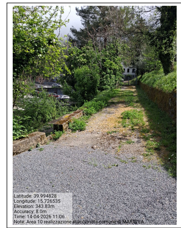
Int. 6.4.2 staccionata sede comunale - Foto 8
