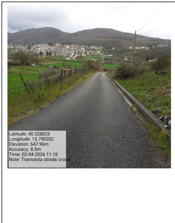
Missione 6.3.2.1 manutenzione strade - Foto11
