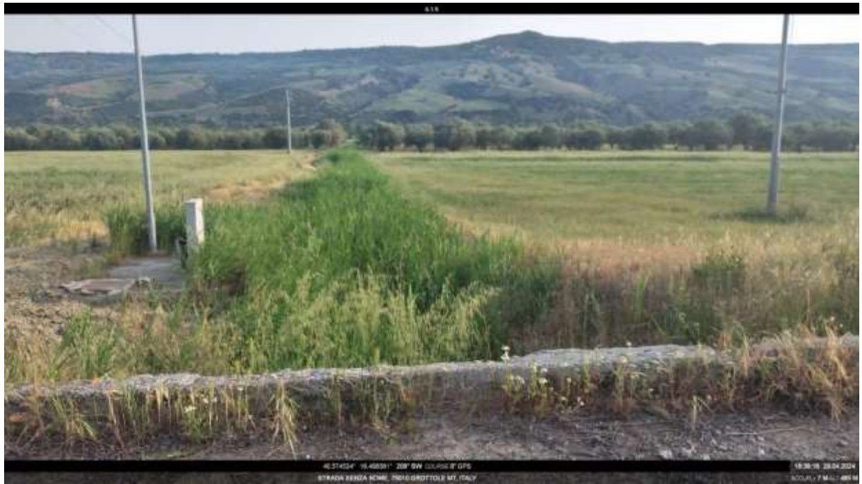
Int. 6.1.9 Grottole Fg.60 Canale 9 Ischia Basento - Foto 23 Lon.40.574524 Lat.16.408381
