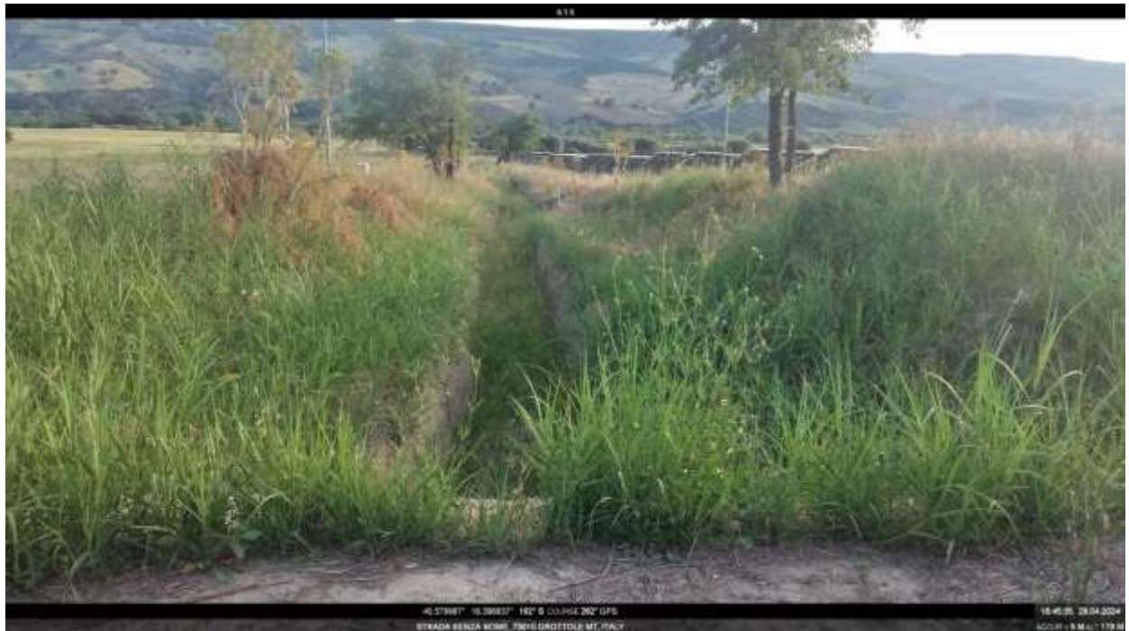
Int. 6.1.5 Grottole Fg.58 Canale 5 Ischia Basento - Foto 19 Lon.40.579967 Lat.16.396637
