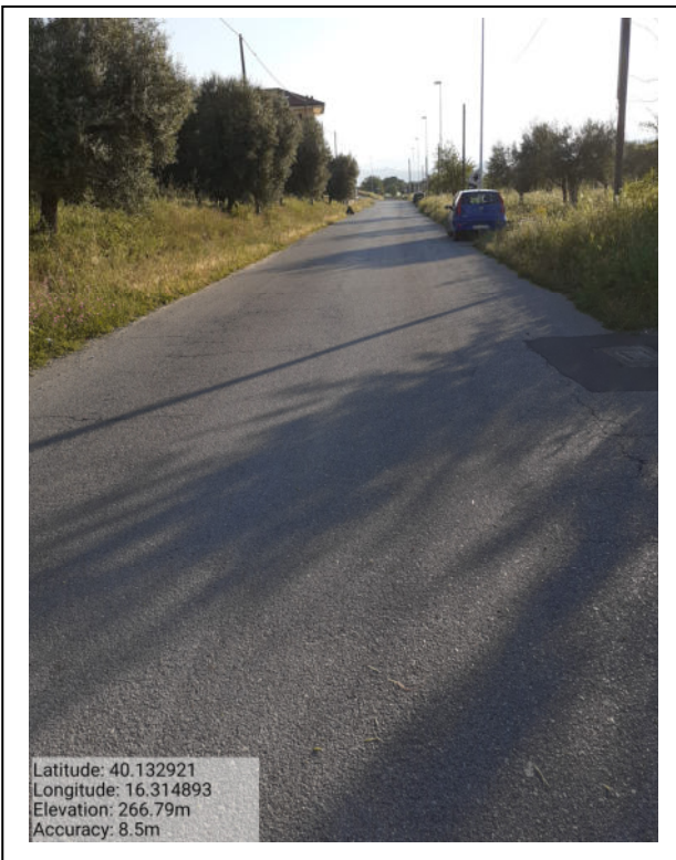
Int. 6.3.3 strada Fanelli - Foto 1
