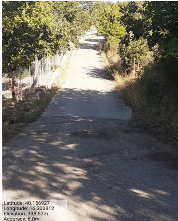
Int. 6.3.6 strada Palmento - Foto1
