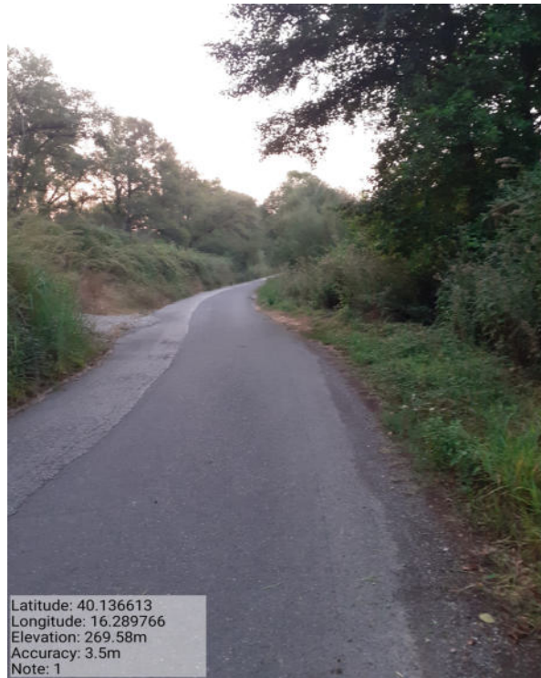
Int. 6.3.18 strada Vigna della Vena - Foto1
