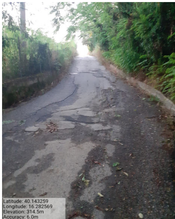
Int. 6.3.17 strada Monaco - Foto1
