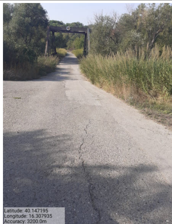
Int. 6.3.15 strada Piano delle Maniche - Foto 1
