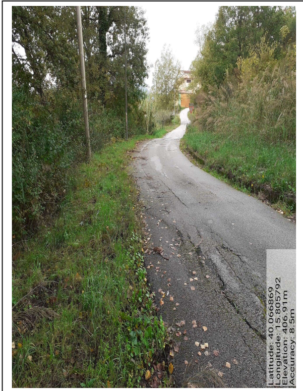
Int. 6.2.2 - strada Piano di Tonne - Concezione - Foto 7
