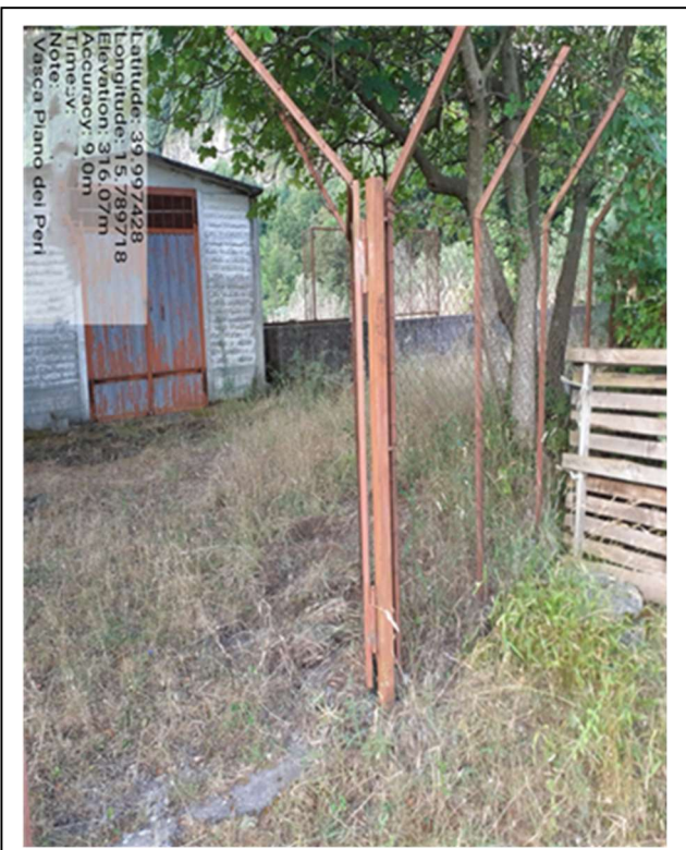
Int. 6.1.2 - vasca accumulo Piano dei Peri - Foto 9
