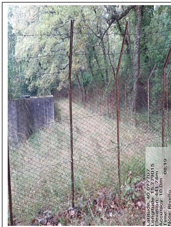
Int. 6.2.1 - Foto 11- vasca di accumulo Mascalcia
