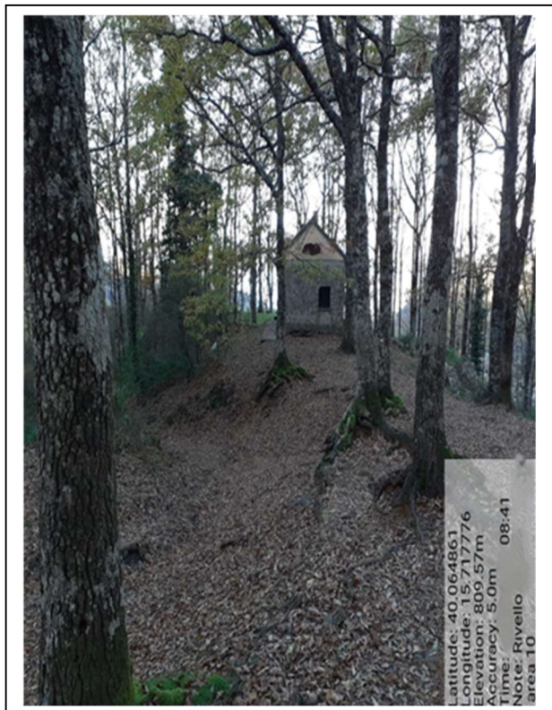
Int.8.1 - realizzazione staccionata Fontanelle - Foto 15
